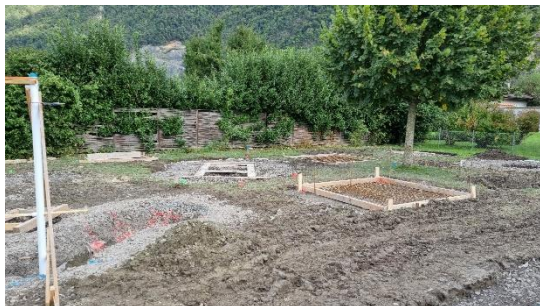
Durant les travaux
