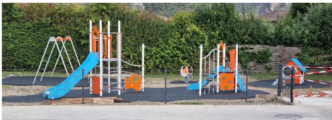
Installation des nouveaux jeux
