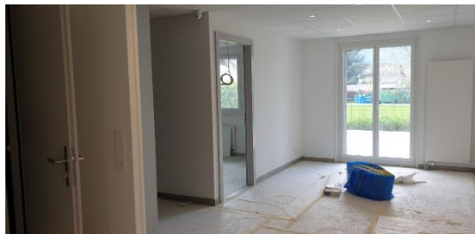
Travaux de réalisation de la cafeteria et du bureau de la bourse
